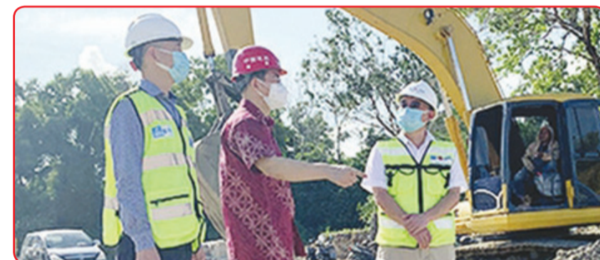
Konjen Zhu Xinglong meninjau progres pengerjaan proyek.
